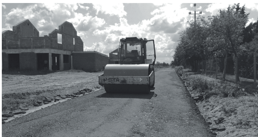
Roboty związane z położeniem destruktu w Walendowie (ul. Ogrody Walendów)
