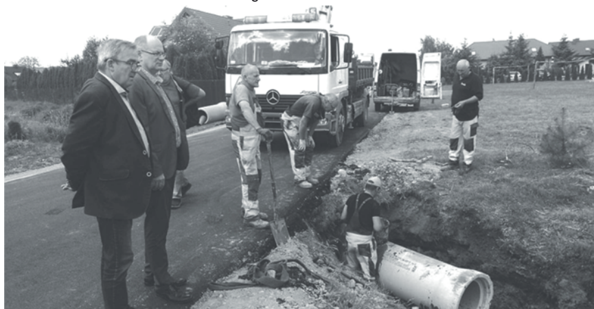
ul. Śródkowa w Ruścu - wraz z naprawą nawierzchni prowadzone były prace związane z wymianą przepustów przy rowach melioracyjnych. Od lewej: Bogdan Perzyna Członek Zarządu Gminnej Spółki Wodno Melioracyjnej Nadarzyn, Dariusz Zwoliński Wójt Gminy
