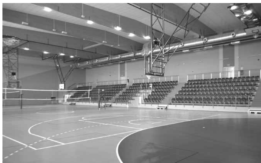
Hala widowiskowo - sportowa.
