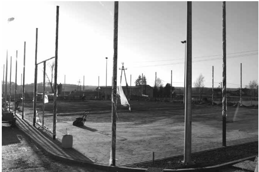
Budowa boiska przy świetlicy Nadarzyńskiego Ośrodka Kultury w Parolach
