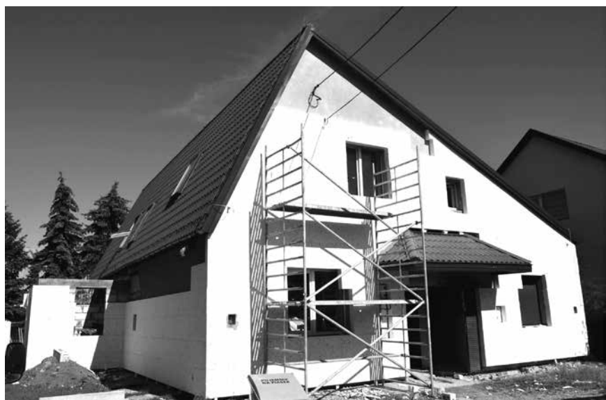
Rozbudowa świetlicy NOK w Urzucie
