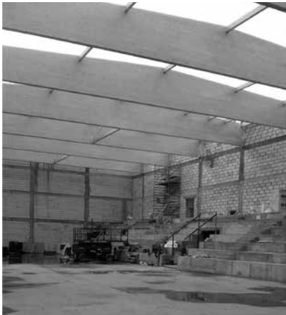
Wnętrze powstającej hali
