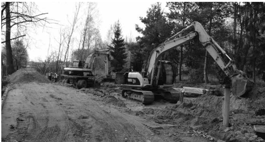
Prace przy budowie oczyszczalni ścieków w Kostowcu
