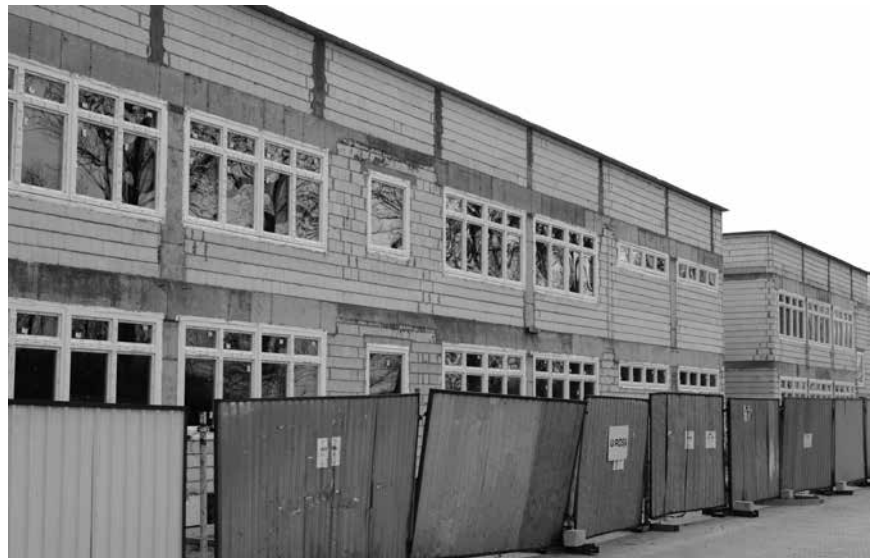
Kompleks oświatowy w Ruścu - powstająca część gimnazjalna
