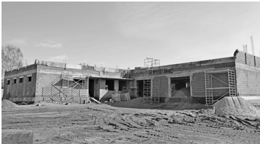
Powstająca świetlica w Parolach
