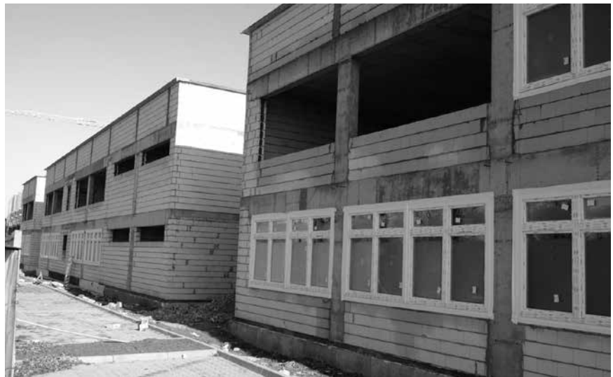
Kompleks oświatowy w Ruścu - w części gimnazjalnej wstawiane są okna
