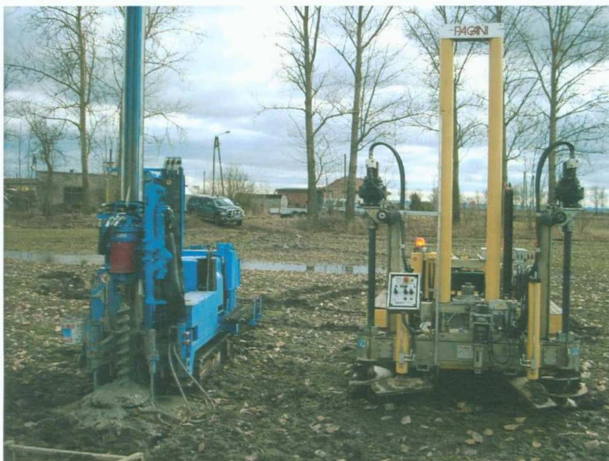
Fot. 1 Po lewej wiertnica NORDMEYER, po prawej urządzenie do wykonywania sondowań CPT - PAGANI typ TG 73-200
