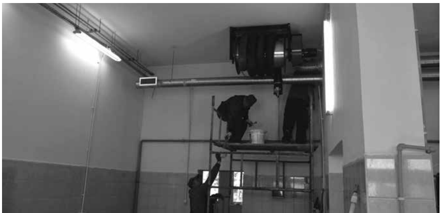
Prace remontowe w siedzibie OSP Nadarzyn
