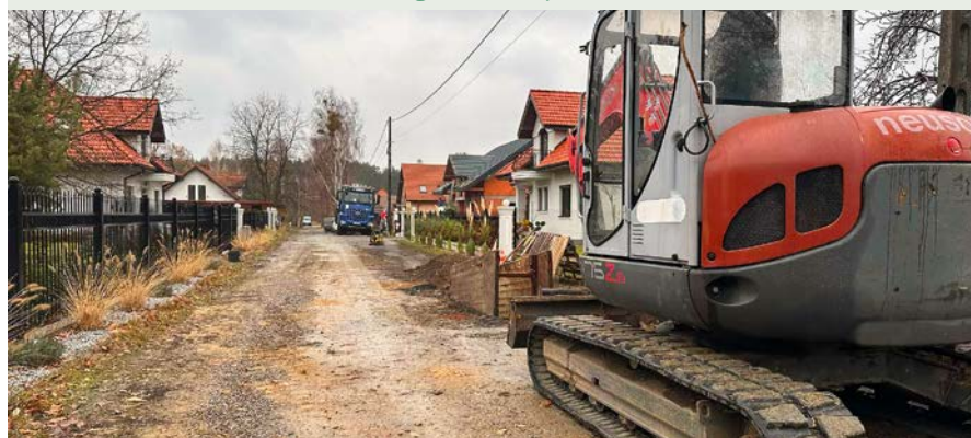
Ruszyła budowa kanalizacji sanitarnej w Starej Wsi
