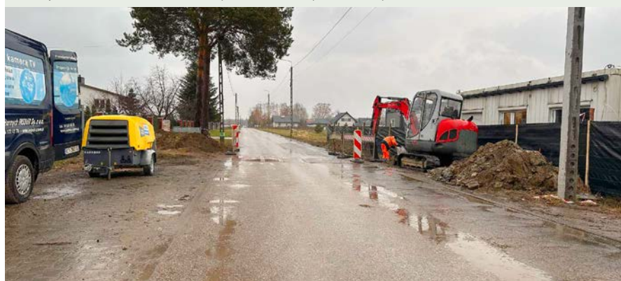
Budowa kanalizacji przy ul. Jemiołowej
