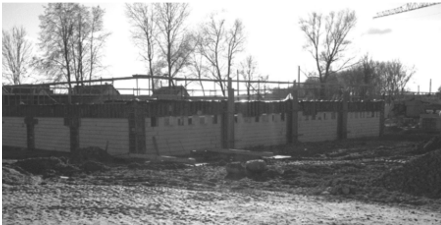
Ostatnie dni listopada 2013 roku - pierwsze tygodnie budowy szkoły w Ruścu
