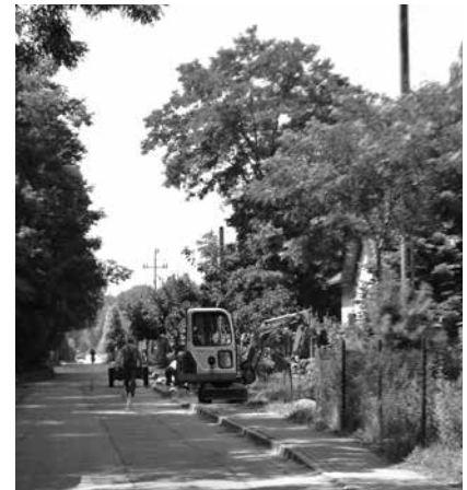
Budowa oświetlenia - ul. Akacyjowa w Nadarzynie
