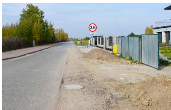
Budowa kanalizacji w Ruścu
