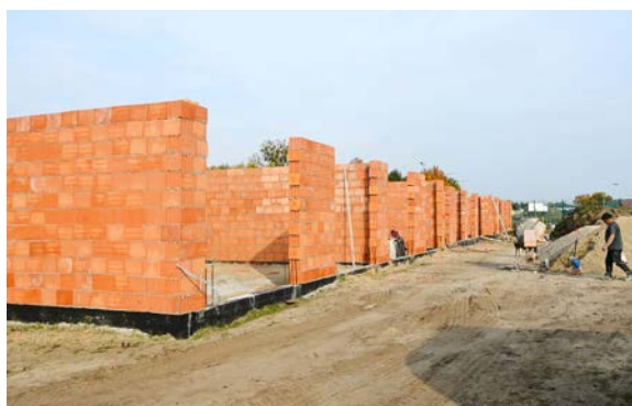
Budowa przedszkola w Wolicy
