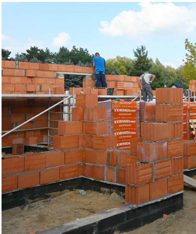
Budowa przedszkola w Wolicy – powstają mury ścian parteru budynku.
