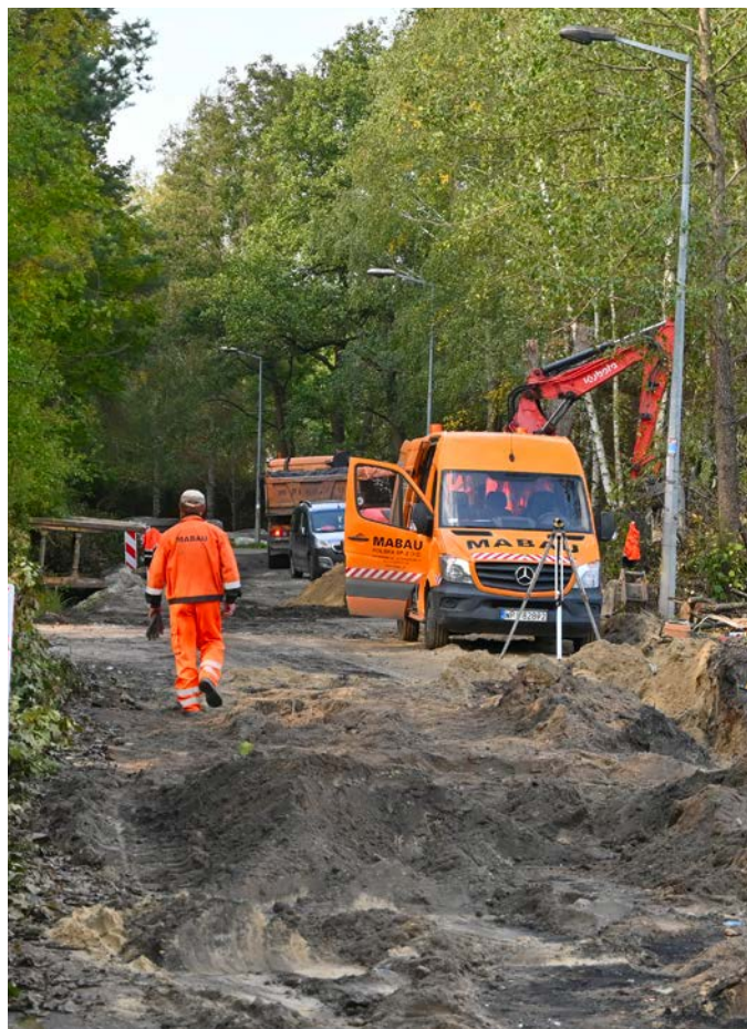
Przebudowa ulicy Głównej w Ruści. Przypominamy o utrudnieniach w ruchu i prosimy o ostrożność oraz zwrócenie uwagi na oznakowanie.
