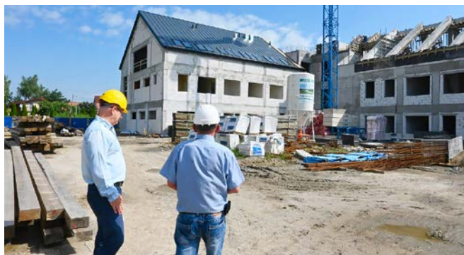
Budowa Zespołu Usług Medycznych
