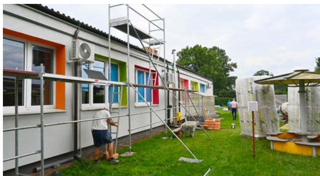
Termomodernizacja żłobka w Ruścu
