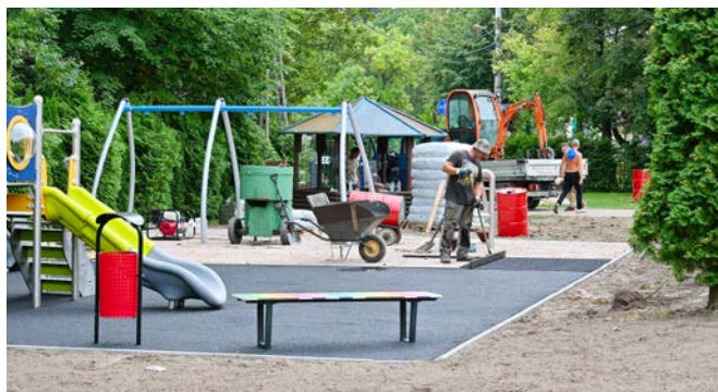
Budowa placu zabaw przy Przedszkolu Publicznym w Nadarzynie
