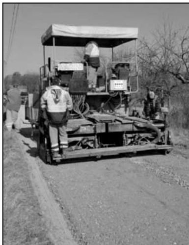
Ul. Słoneczna w Walendowie wzmocniona została tłucznem kamiennym.
