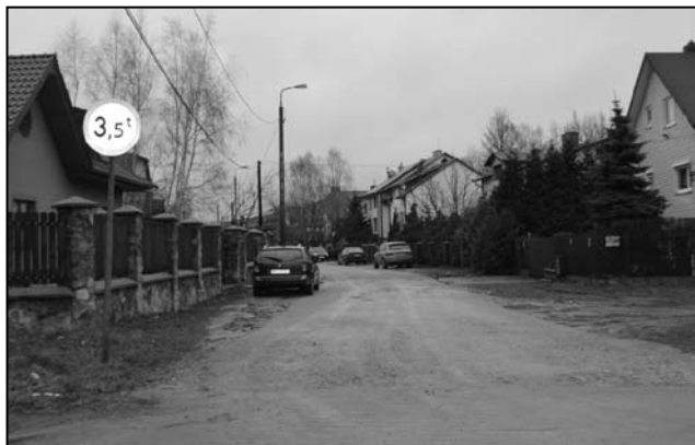
Wzmocniona tłucznem nawierzchnia ul. Narcyzowej w Nadarzynie.
