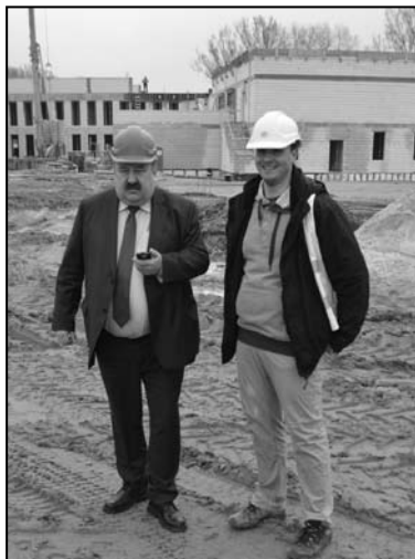
Wójt Gminy Janusz Grzyb podczas jednej z roboczych wizyt na budowie kompleksu w Ruścu. Z prawej kierownik budowy Krzysztof Urbanelis.
