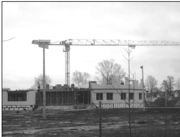
Plac budowy kompleksu oświatowego w Ruścu - marzec 2014 r.:
