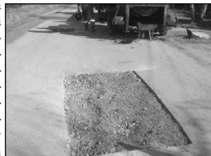
Remont cząstkowy nawierzchni bitumicznej - ul. Graniczna w Nadarzynie.
