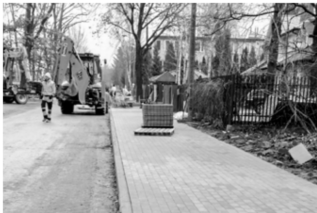
Prace przy ul. Sitarskich w Nadarzynie
