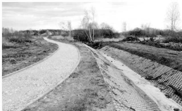
Budowa odcinka Urzut - Stara Wieś
