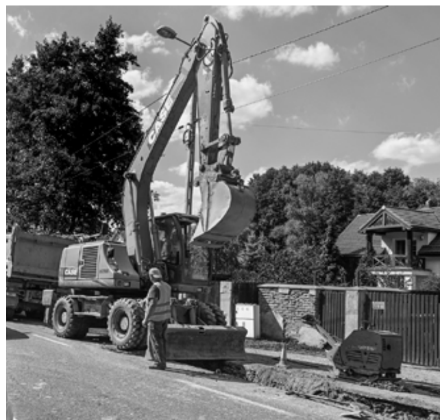
Budowa kanalizacji na ul. Grodzkiej w Starej Wsi
