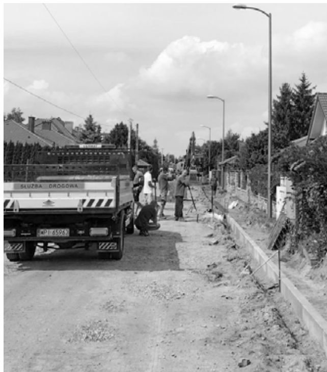
Budowa ul. Poranka w Kajetanach
