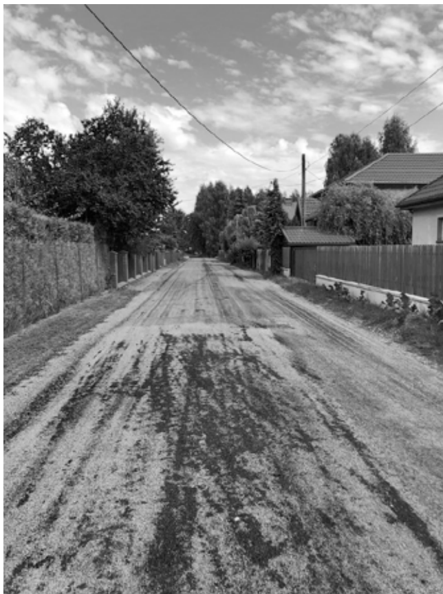
Utwardzona destruktem ul. Mazurska w Nadarzynie
