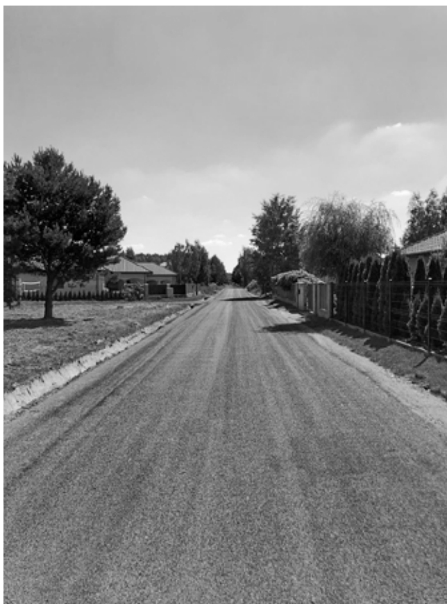
Utwardzona destruktem ul. Diamentowa w Ruścu
