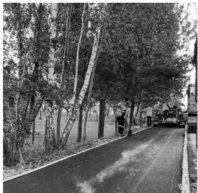
Ścieżka rowerowa w Krakowianach Referat Inwestycji
