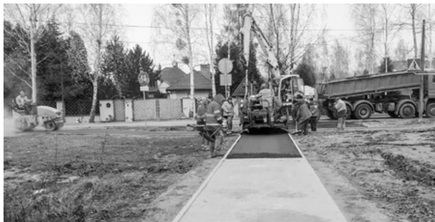
Prace na ul. Grodzkiej w Starej Wsi
