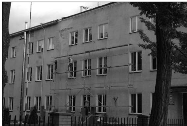
Prace w SP Kostowiec obejmowały m.in. remont dachu, gładzi i gzymsów.
