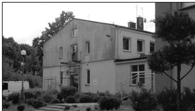
W szkole w Woli Krakowiańskiej oprócz prac wewnątrz m.in. remontowana była frontowa część budynku.
