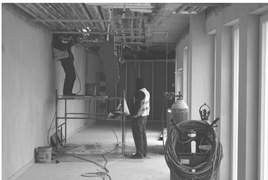
Montaż instalacji sanitarnych i elektrycznych - szkoła w Ruścu
