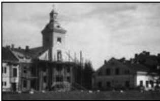
Budowa kaplicy w Walendowie (lata trzydzieste XX w.).
